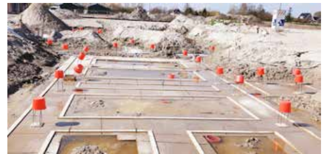
Gestorte fundering. De oranje emmertjes zitten over de wapeningsstaven heen. Dit is voor de veiligheid en bescherming van de werknemers.
