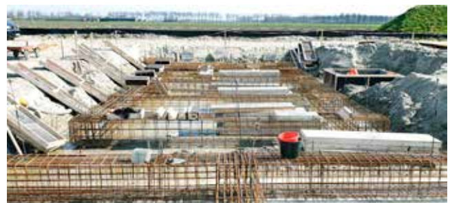
Betonnen fundering en daarop de wapeningsstaven.
