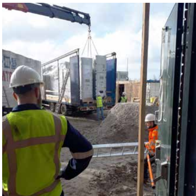
Boven en onder: montage van de 20kV - middenspanningsapparatuur
