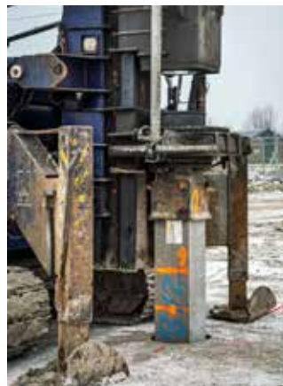
Heien van de palen met een kleine hei-installatie
