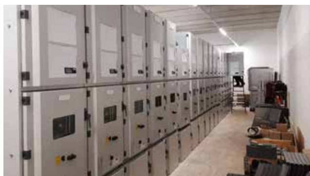
Boven en onder: montage van de 20kV - middenspanningsapparatuur
