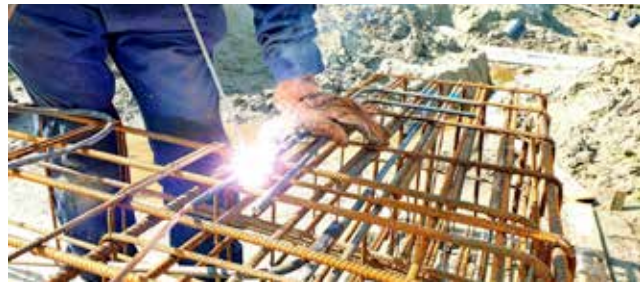
Lassen van de constructie van de fundering.
